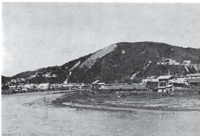
図版 8 河原屋から柵原鉱山を望む
