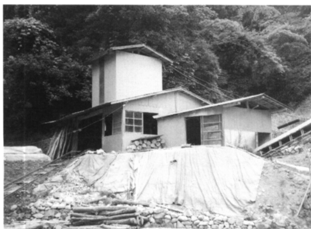
第9.3図 鍋山鉍山の立坑坑口
