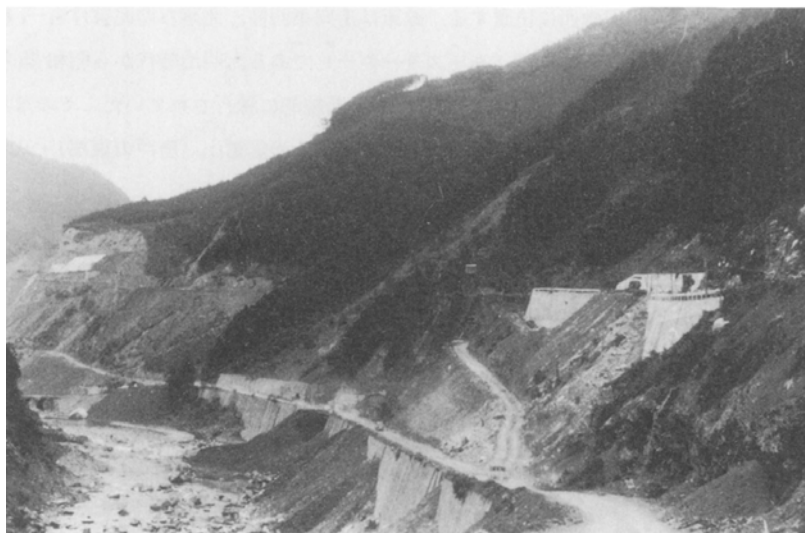
第34図 川上村大迫ダム付近の地すべり（1967年7月、志井田写）
