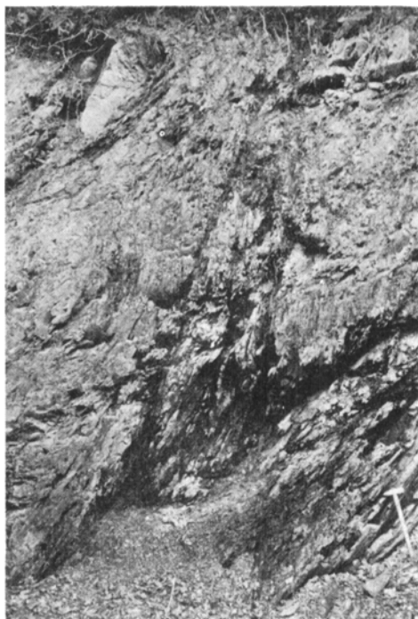
図版9 断層に伴って見られる地層の擾乱（富貴村東富貴南方）
