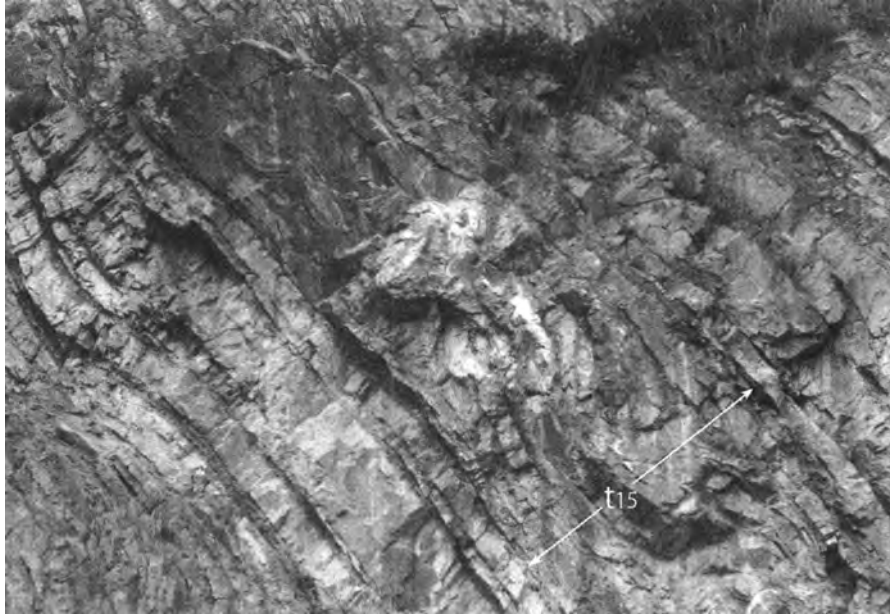
第 5.7 図 和泉層群酸性凝灰岩 ( t_{15} ) の露頭写真 岩出層 I_{3-4} 下部に挟まれる。凝灰岩層の厚さは約 2.4 m で、73.1 Ma の F.T. 年代 (第 5.1 表参照) が得られている。右 (南東) 方向に移動したスランプ褶 曲がみられる (和歌山県岩出町風吹隧道北方の採石場)
