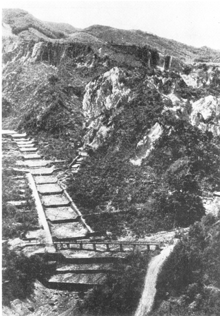
第74図 太多田川座頭谷の砂防ダム Land erosion control dams at Zato-dani of the Ōtata River
