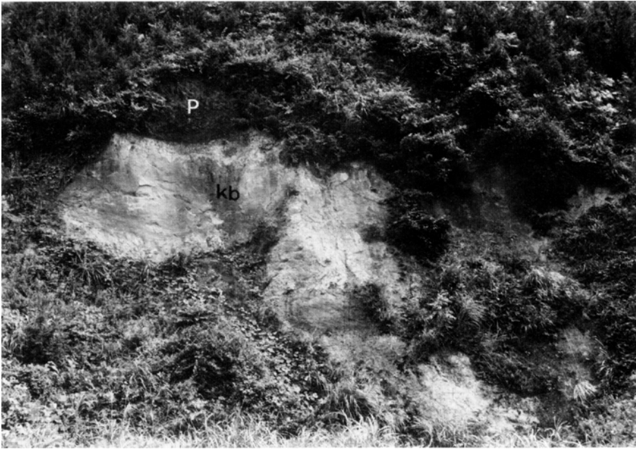
1 綿向山断層の露頭 (古生層(P) が古琵琶湖層群 (Kb) に衝上している。N10° W, 50° Eの断層面が写真向い側の山腹にも露出する) (日野町水無山西側山腹の林道)
