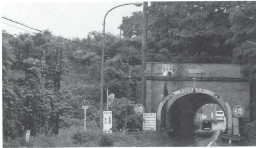
第27図 天井川となった百瀬川 トンネルの背後の高まりが百瀬川の堤防（マキノ町沢の南方の百瀬川隧道）。
