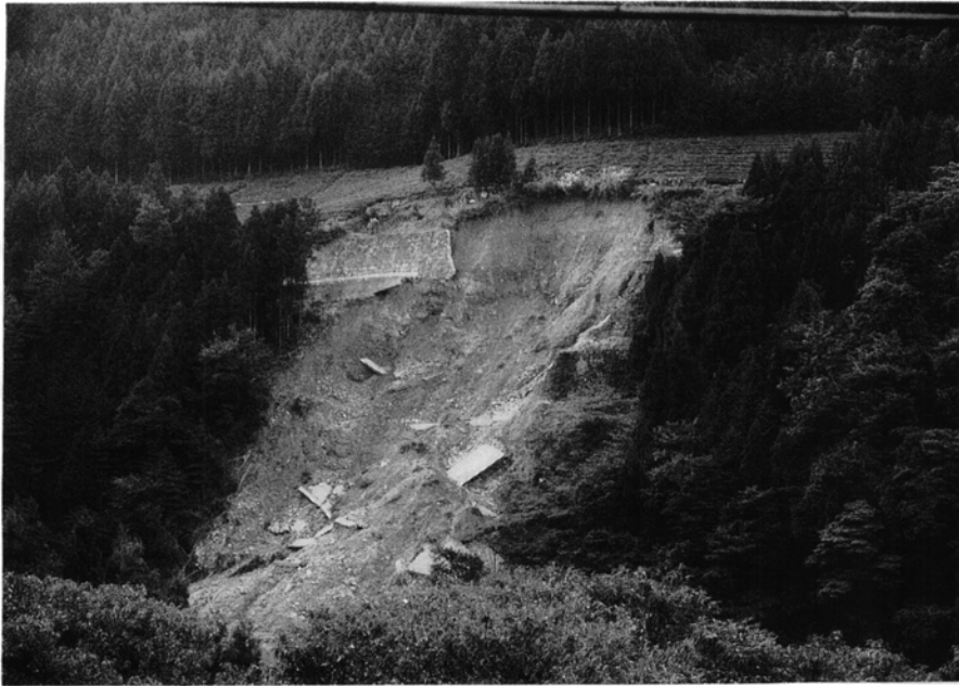
第39図 平成元年9月初旬の集中豪雨による道路の崩壊 久瀬村三倉北方
