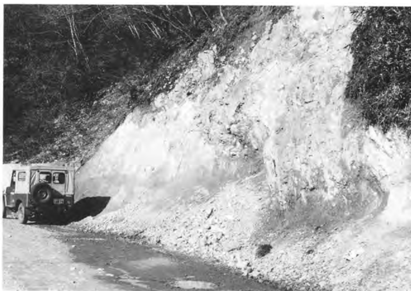
第22図 山之口断層による溶結凝灰岩中の破碎帯。山之口川東岸，山之口，上田北方2 km
