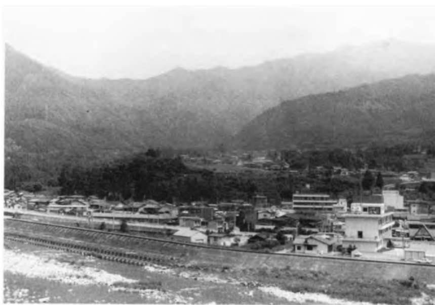
第16図 萩原町桜洞の段丘地形。手前の低位面は飛驒川本流の河岸段丘堆積物, 後方の高位面は桜谷の扇状地性堆積物から構成される。萩原町吉関北方から展望
