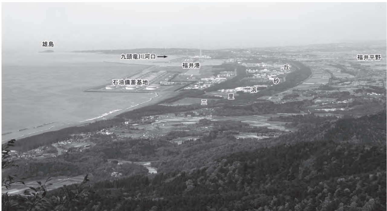
第 2.9 図 南西側からみた三里浜砂丘 福井港周辺の臨海工業地帯建設に伴い、砂丘の形状の大半が失われている。
