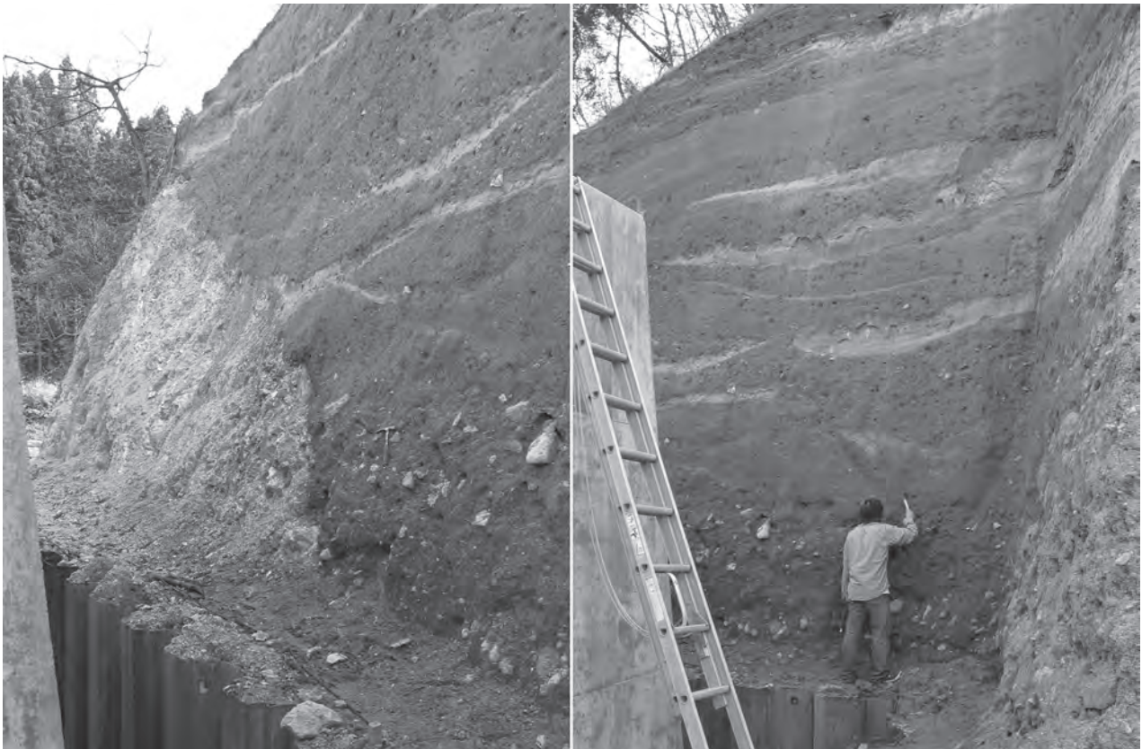
第4.1図 高位河成段丘堆積物の露頭 福井市西別所町の造成工事現場。下位の糸生層を削り込み、これを不整合に覆っている。
