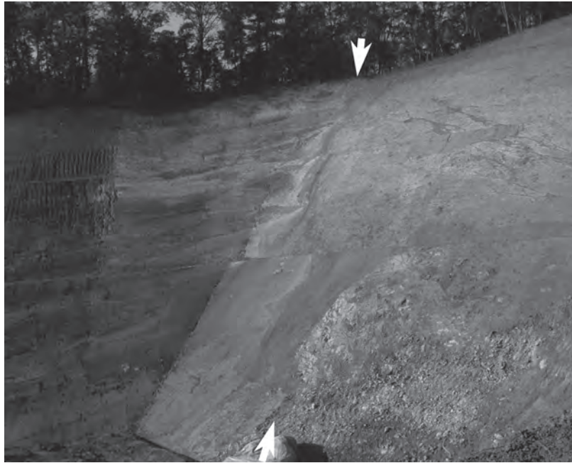
第5.2図 福井市西別所町の造成工事現場に出現した活断層露頭 断層南側（写真左）は高位河成段丘堆積物，北側（写真右）は風化した糸生層の凝灰岩となっている。
