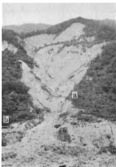
a: 砂防堰堤 b: 工事用見張小屋
