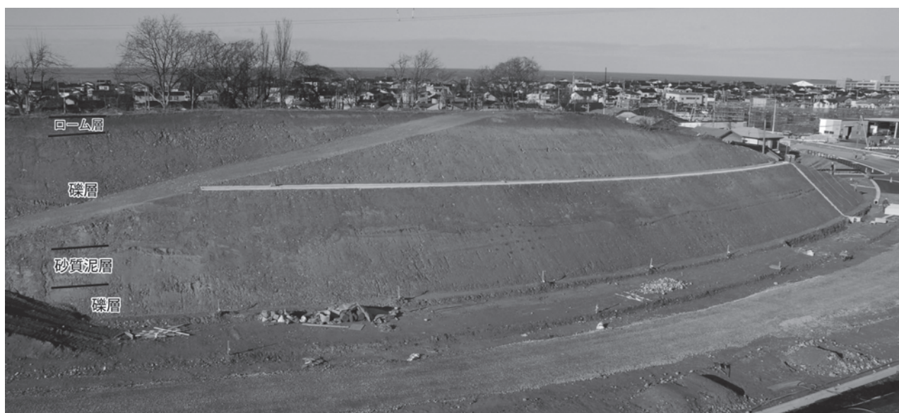
第 6. 12 図 道路工事で露出した中位 II 段丘堆積物 礫層に層厚約 1 m の砂質泥層が挟まる。糸魚川市大和川 (Loc. 12)。位置は第 6. 3 図参照
