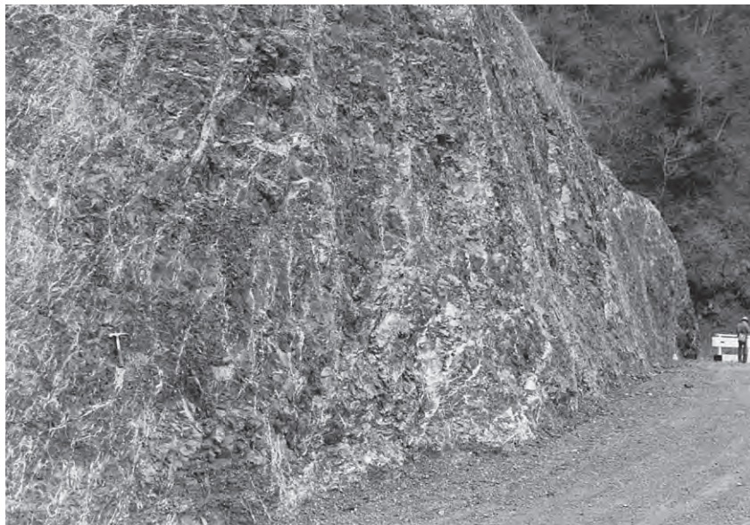
第 7. 6 図 白色脈を伴う破碎された月夜凝灰岩部層 月夜の段の南側、林道法面。
