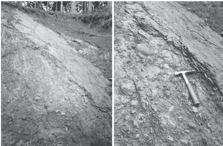
第10.11図 徳間断層の露頭 富士川上流の下村北東方の鯨野上徳間林道脇(第7.10図のLoc.7767A)。貫ヶ岳礫岩部層と徳間火砕岩・砂岩泥岩互層部層が西傾斜の逆断層で接している。
