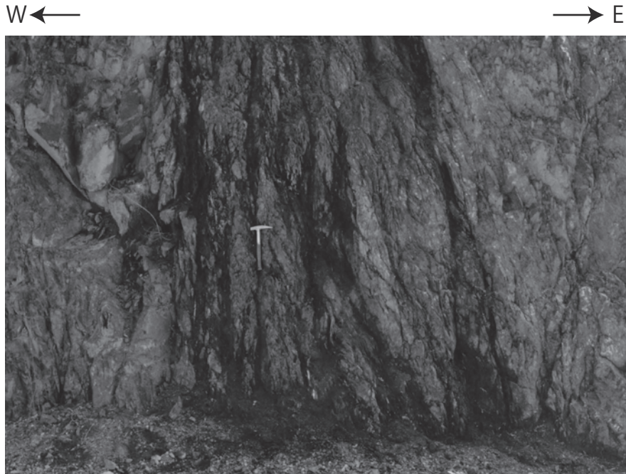
第 5. 9 図 大野原層の破碎された泥岩 地点：早川町早川 (付図 2A 参照)。層理面に沿って幅約 2 m の断層破碎帯が発達する黒色泥岩 (Om)。断層破碎面全体の走向傾斜は約 N10°, W90°。ハンマーの長さは約 33 cm。
