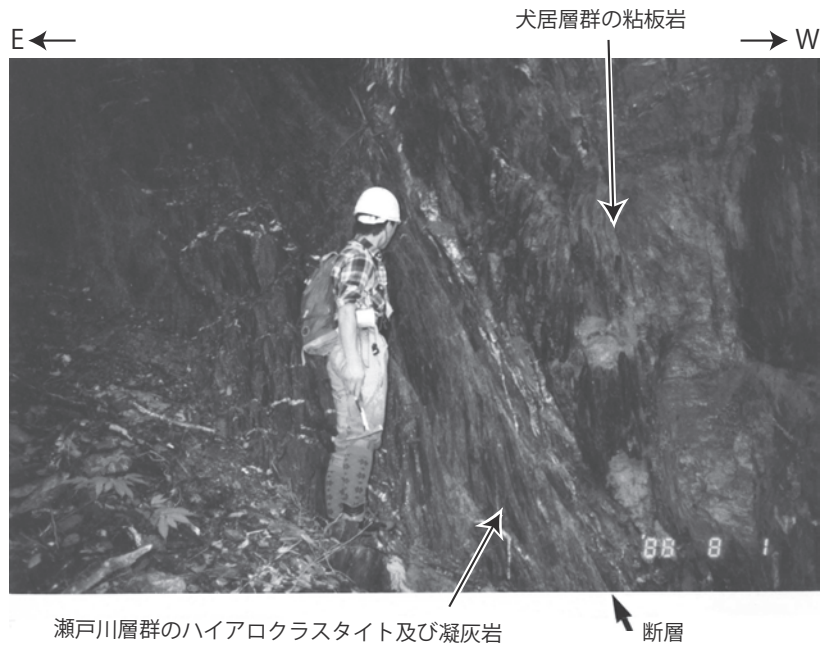
第 10. 3 図 早川支流の保川における笹山構造線の露頭 犬居層群の粘板岩が片状化した瀬戸川層群の玄武岩ハイアロクラスタイト及び凝灰岩に衝上する。断層面の走向傾斜は N35^{\circ}E, 70^{\circ}W 。地点は付図 2A 参照。
