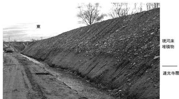
第9.7図 多摩川の現河床堆積物 場所は日野市日野の日野橋下の改修工事露頭（付図の地点97）。現河床堆積物が連光寺層を覆う。現在この露頭は消滅している。露頭の高さは約4m。
