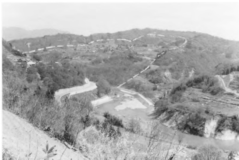
第50図 善光寺地震によって生じた虚空蔵山の大崩壊地(正面後方:虚空蔵山, その手前:湧池, 点線内:崩壊地)
