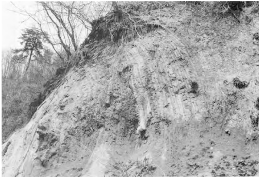
第19図 論地泥岩部層の最上部に発達する砂岩優勢の砂岩泥岩互層(信州新町山上条伎管)
