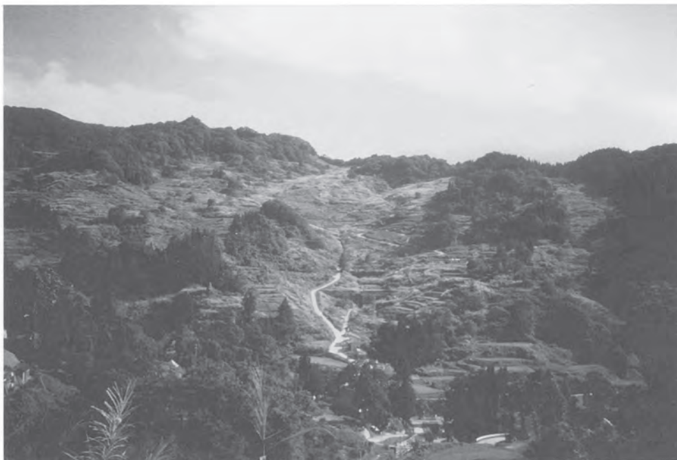
第63図 八幡地すべりの全景。 中央部が蛇香沢で、最も変動が激しい。
