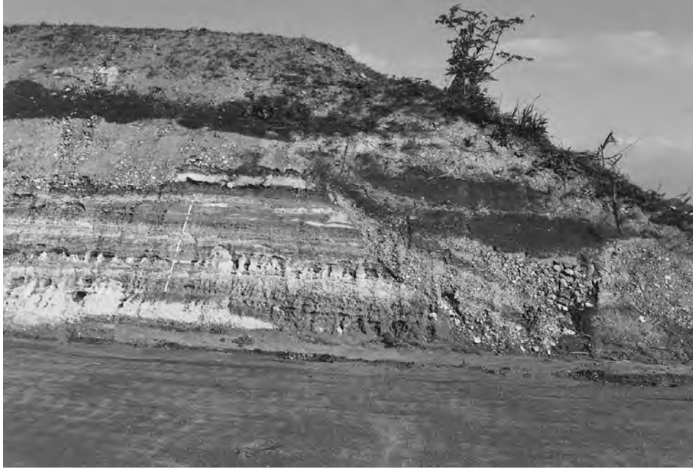
第7.7図 埋没した低位I段丘堆積物とそれを削り込む最低位I段丘堆積物 新鶴村新屋敷。低位I堆積物は細かく成層したシルト及び砂からなり、腐植質シルト層を挟む。スケールは2m。
