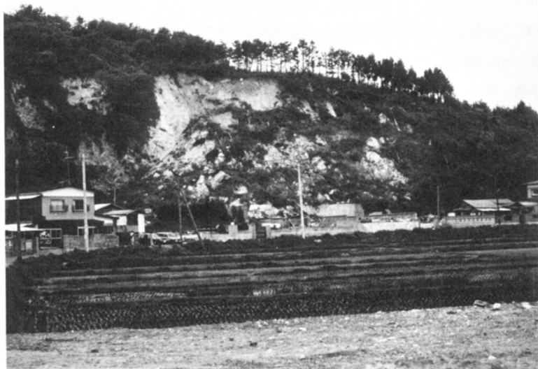
第76図 1978年宮城県沖地震によって発生した崖崩れ(松島町城内南方、撮影地点は第12図に示す)
