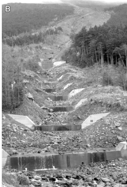
第13.3図 早池峰山北方斜面のアイオン沢崩壊 A：斜め空中写真（1988年5月撮影）。発生域はa付近（積雪のため不明瞭）。崩壊土砂はb付近で沢に流入し、堆積していた厚い土砂を巻き込みながら流下した。d付近で低い尾根を乗り越え、地山を削剥しながらほぼ直進して握沢に達した。一部はもともとの沢筋（石倉沢）を流下している。c付近にはその後発生した崩壊もみられる。Yは閘間沢崩壊の発生位置。 B：d地点付近(39° 34' 42" N, 141° 28' 47" E)から上流側を望む（1985年10月撮影）階段状に砂防ダムが建設されている。沢筋のみならず、両袖部も岩屑からなっている。数m大の巨礫も所々に認められる。厚い岩屑は上流部まで続いている。沢に沿っては樹齢の若い林となっており、継続的な土砂移動が起こっていることが推察される。
