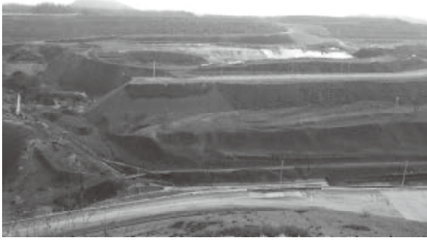
第8.5図 鉍滓盛土の写真
