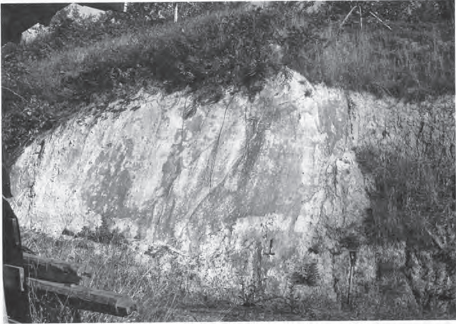
第66図 尾崎付近の急傾斜した青荷凝灰岩
