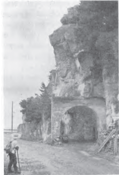
第13図 深浦海岸・猿鼻洞門の六角沢凝灰岩 ここでは凝灰角礫岩が多い
