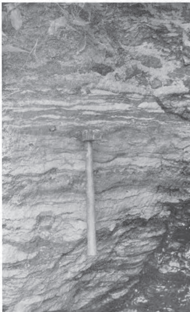
第33図 北一鉱床付近，鉄橋の下に露出するマンガン鉱層 黒縞がマンガ 白い部分は凝灰質砂岩
