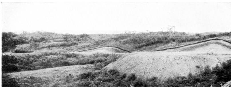
第3図 栄西方の新道切割に露出する磯分内軽石流 標高100m
