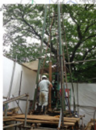
ボーリング調査の様子
