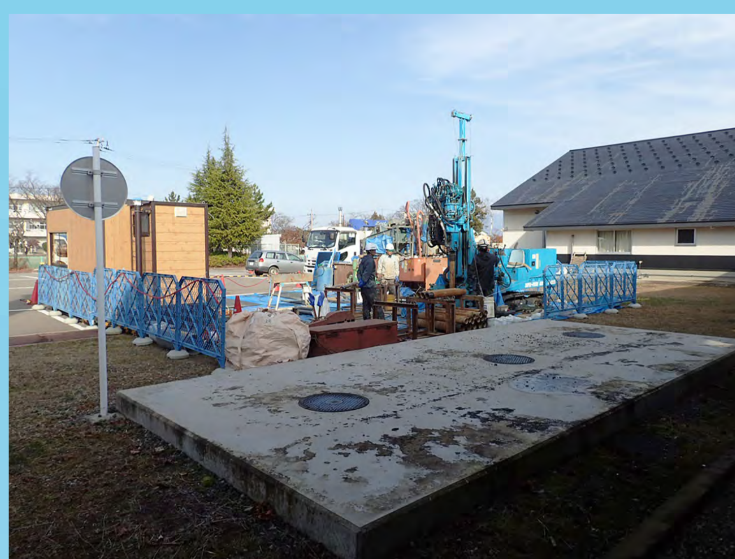
地下水、地質の調査
