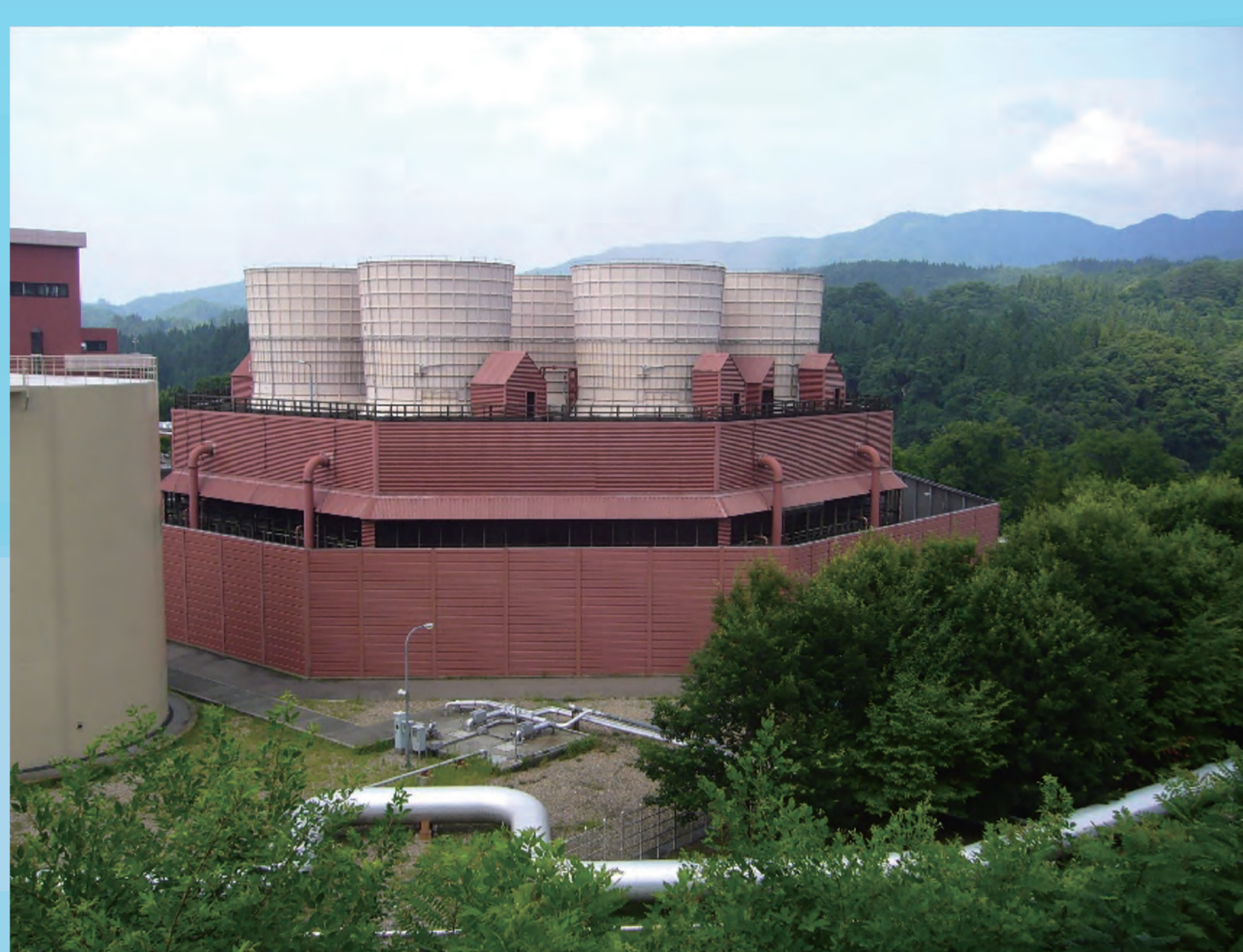
柳津西山地熱発電所 (福島県)
