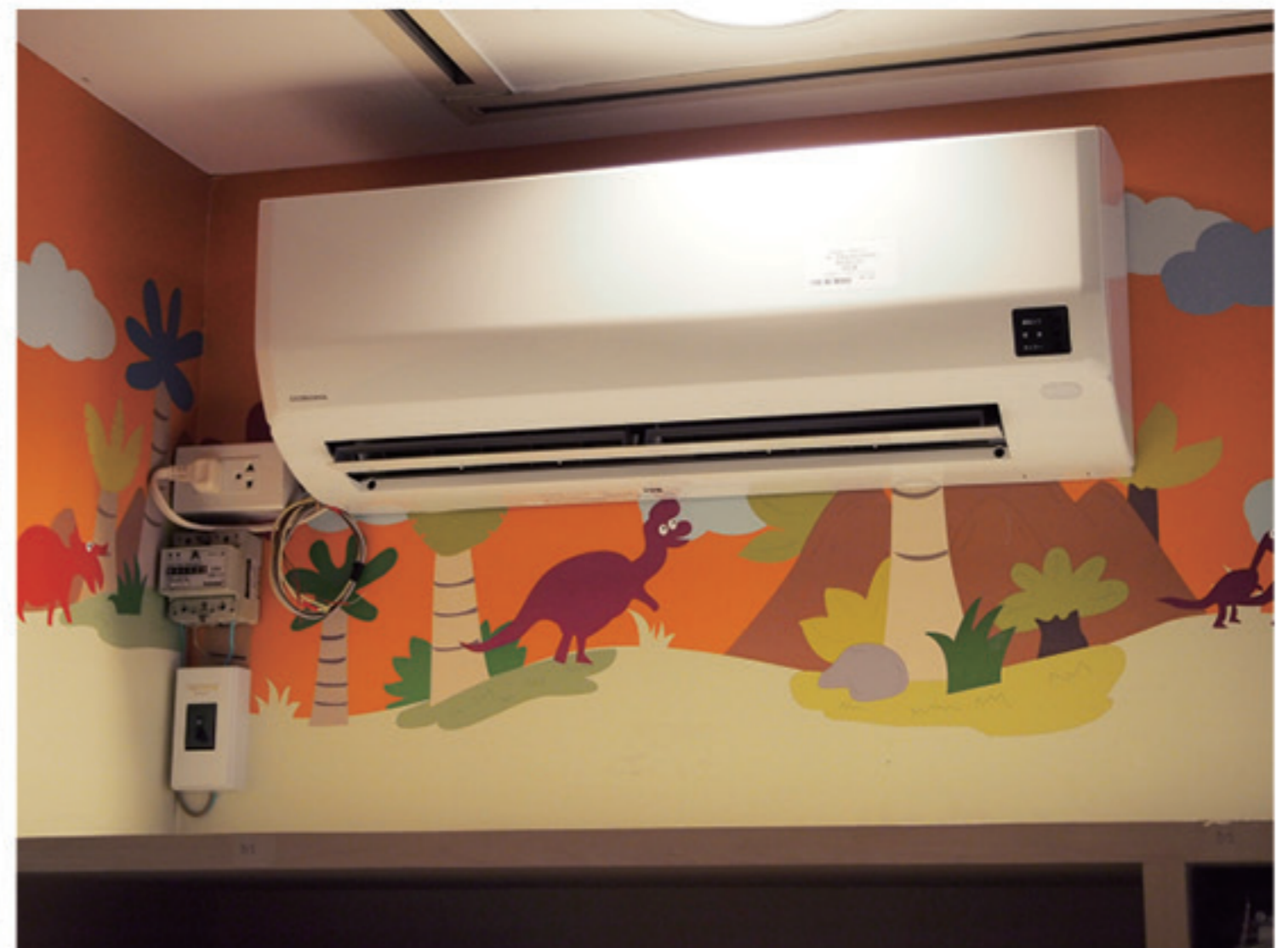
写真1. タイ地質博物館での地中熱交換パイプ設置の様子（左）と博物館お土産ショップの地中熱ヒートポンプシステム（右）。
