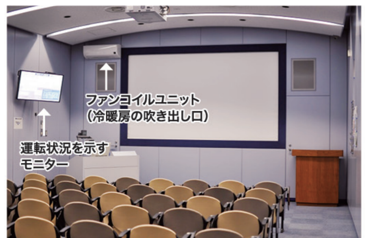
図1 地質標本館（上）と地中熱ヒートポンプシステムを導入した1階映像室（下）。
