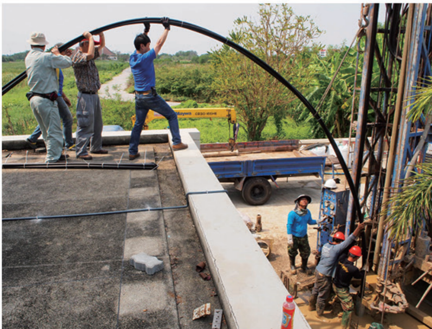
写真1. タイ地質博物館での地中熱交換パイプ設置の様子（左）と博物館お土産ショップの地中熱ヒートポンプシステム（右）。
