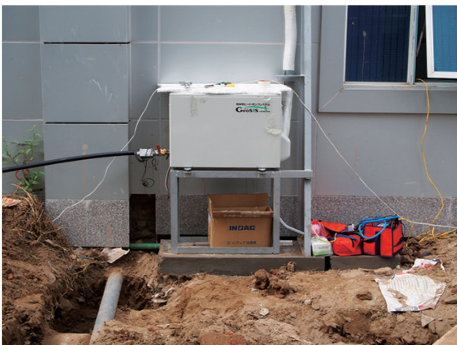
写真2. ベトナム地球科学鉱物資源研究所に設置された地中熱ヒートポンプシステム（左）、建物でのヒートポンプ機能にはエアコンの機器を利用（右）。
