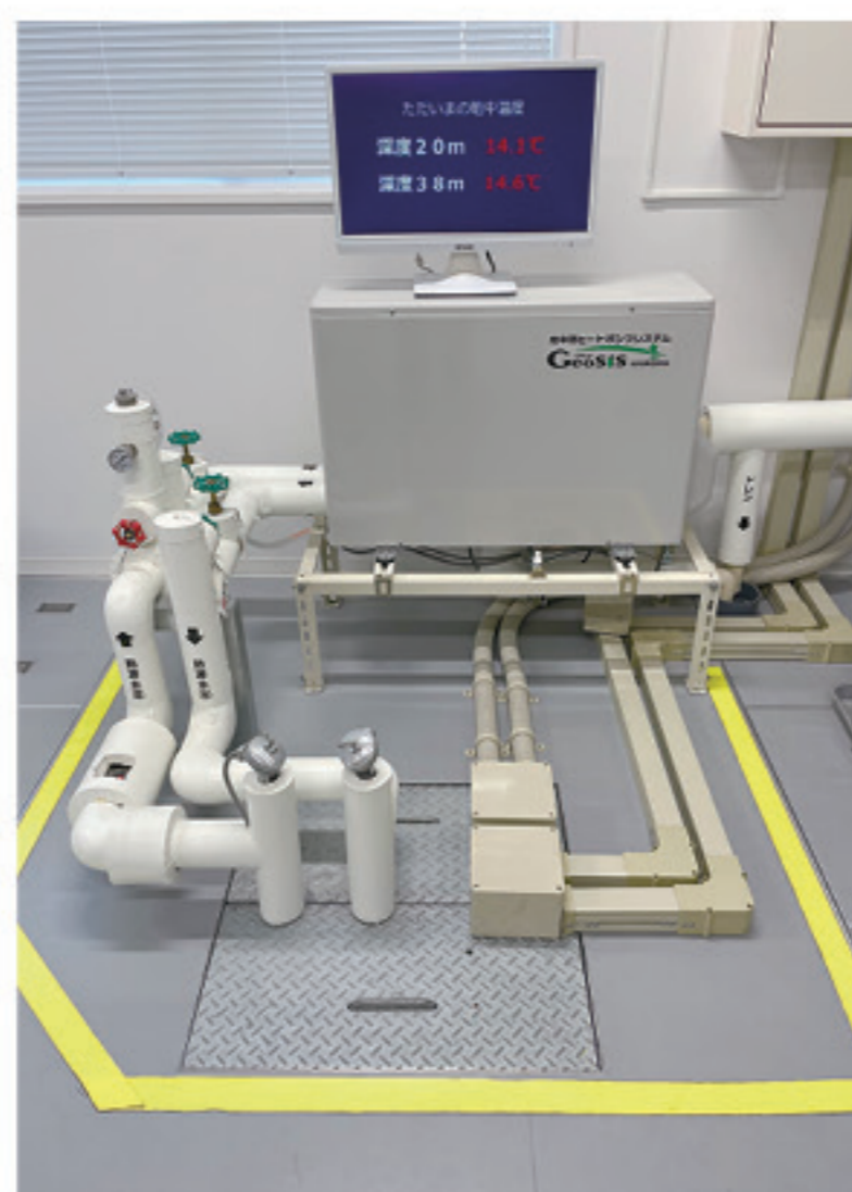
図2 福島再生可能エネルギー研究所で実証試験中の地中熱ヒートポンプシステム。地中熱ヒートポンプ（左）、屋外の様子（右）。
