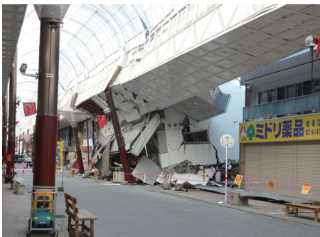
(撮影：熊本大学 松田泰治) ④ 倒壊したショッピングセンター
