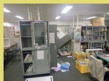
館外に移転していた事務室では多くのつっぱり棒が機能したが、一部は外れてロッカー類が転倒した（2016年4月16日撮影）
