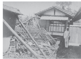
⑦ 熊本監獄内土塀崩壊
