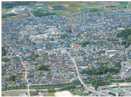
(撮影：熊本大学 鳥井真之) ② 益城町役場付近の状況（多くの被災住宅の屋根がブルーシートに覆われている） 国土交通省の協力により 2016 年 5 月 14 日撮影
