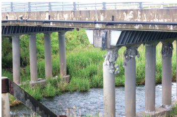
(撮影：熊本大学 葛西 昭) ① 橋脚が損傷した第一畑中橋
