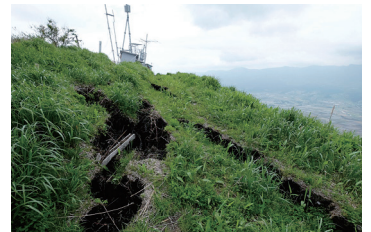
(撮影：熊本大学 鳥井 真之) ⑧ 夜峰山の尾根沿いに亀裂が続く
