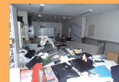
1F 事務室内の状況（2016年4月17日撮影）
