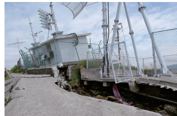
(撮影：熊本大学 鳥井 真之) ⑦ 夜峰山山上のテレビ中継所の被害
