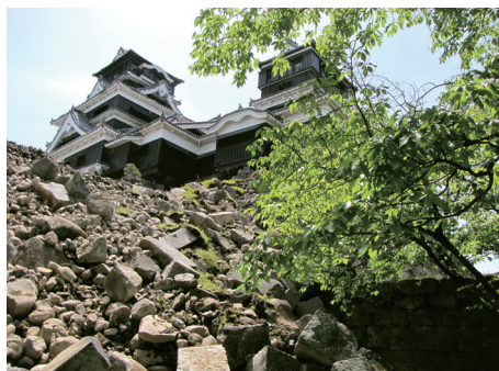
（撮影：熊本大学 山尾敏孝） ① 熊本城小天守下の石門上の石垣部分の崩壊
