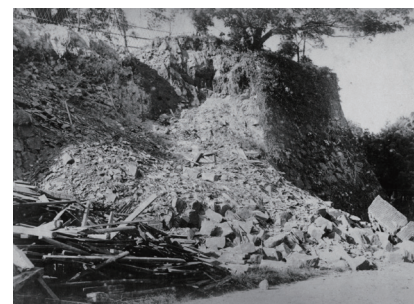
③ 旧熊本城西出丸 第六師団火薬庫崩壊
