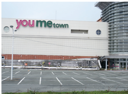
(撮影：熊本大学 柿本竜治) ⑤ 大型店舗の屋根がすべて崩落した
