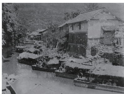
⑨ 飽田郡高橋町負傷者船住居
