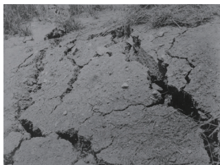
④ 旧熊本城平左衛門櫓 床第六師団号砲台裂地
