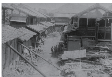
⑩ 飽田郡高橋町字川端家屋崩壊
