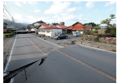
(撮影：熊本大学 鳥井真之) ⑩ 阿蘇カルデラ内に形成された大きな陥没
