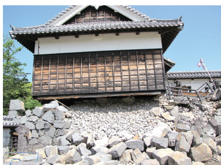
（撮影：熊本大学 山尾敏孝） ①' 南大手門の元太鼓櫓の損傷及び石垣の崩落と裏栗の状態
