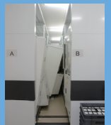
収蔵庫の被害状況。固定棚（A列）のキャビネットは転倒したが、可動棚（B列）のキャビネットは転倒しなかった
